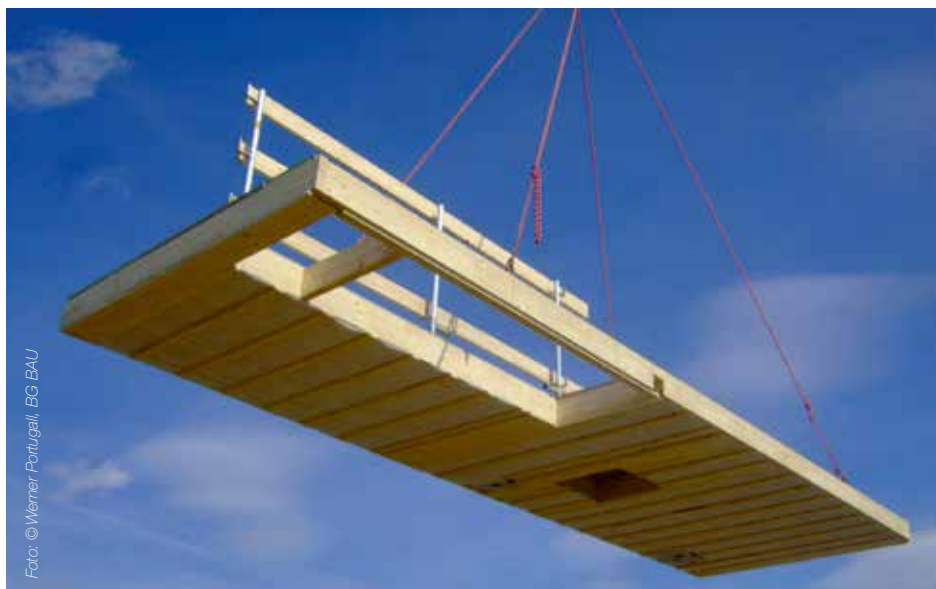
Abb. 4: Ein bereits am Boden angebrachter Seitenschutz steht sofort nach Verlegung des Deckenelements zur Verfügung und verhindert zuverlässig einen Absturz durch das Treppenloch.
