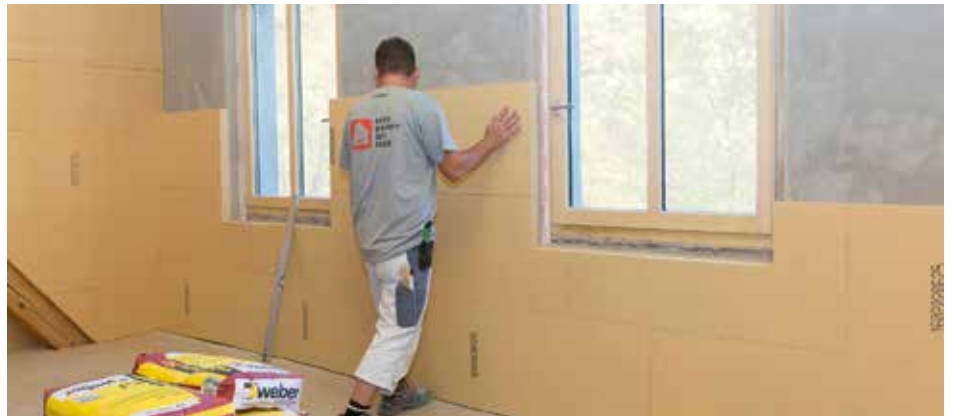
Großes Plus in der Verarbeitung: Die Holzfaserdämmplatte Thermoroom wird nicht mechanisch befestigt, sondern mit Klebe- und Spachtelputz auf den Untergrund geklebt – und das witterungsunabhängig über das gesamte Jahr. Foto: GUTEX
