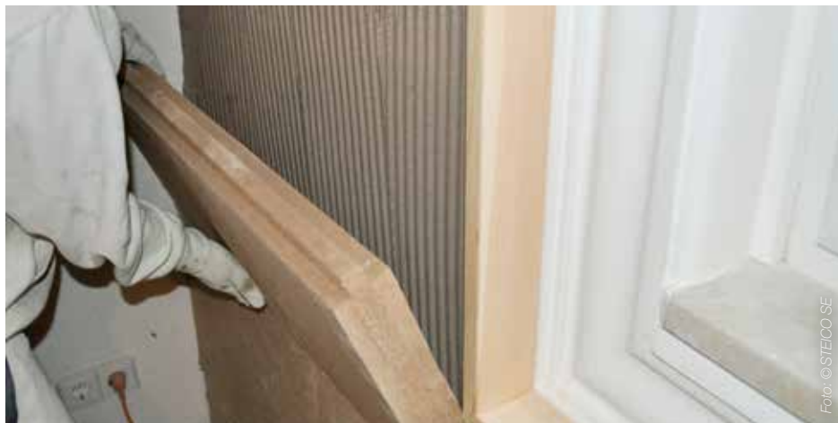
Abb. 2 Die Holzfaserdämmplatten werden vollflächig auf der Bestandswand verklebt.
