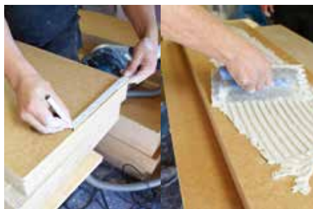
Abb 2 STEICOinternal ist im handlichen Format 1.200 x 380 mm mit stumpfer Kante (Dicke 40 / 60 / 80 mm) oder mit Nut und Feder (Dicke 40 / 60 mm) verfügbar. Bildrechte: STEICO
