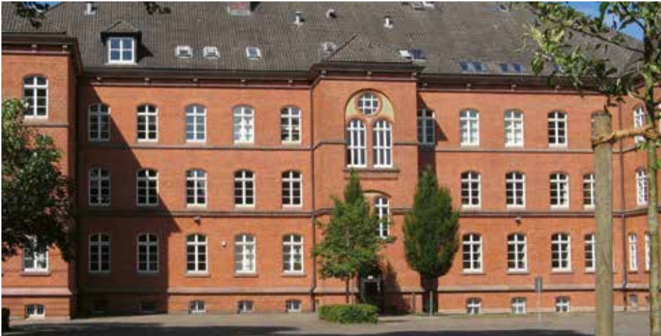
Abb. 1 Typische Fassade mit Verblendmauerwerk (Baujahr 1892)
