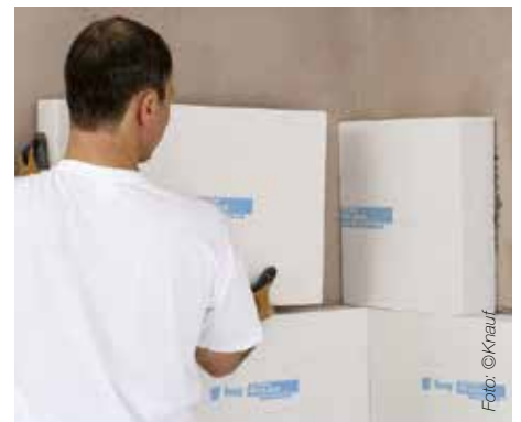
Abb. 5 Die mineralischen Dämmplatten werden mit einem kapillaraktivem Mörtel im Vollkontakt mit dem vorhandenen Innenputz montiert.
