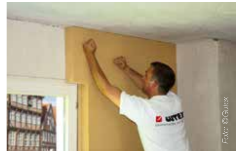
Abb. 4 Die Holzfaserdämmplatten werden im Vollkontakt mit dem vorhandenen Innenputz montiert.
